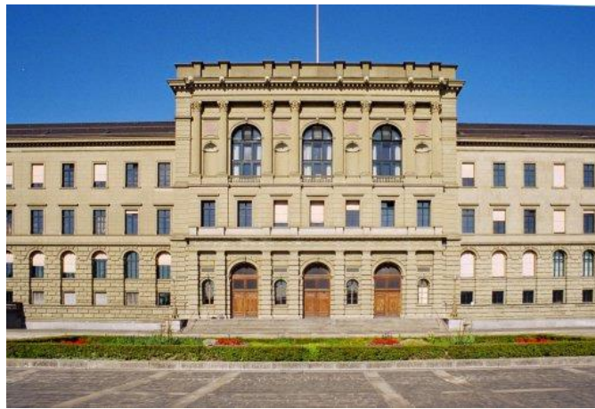
Slika 22: Glavna zgrada Politehnike u Cirihu izgrađena 1864. godine
